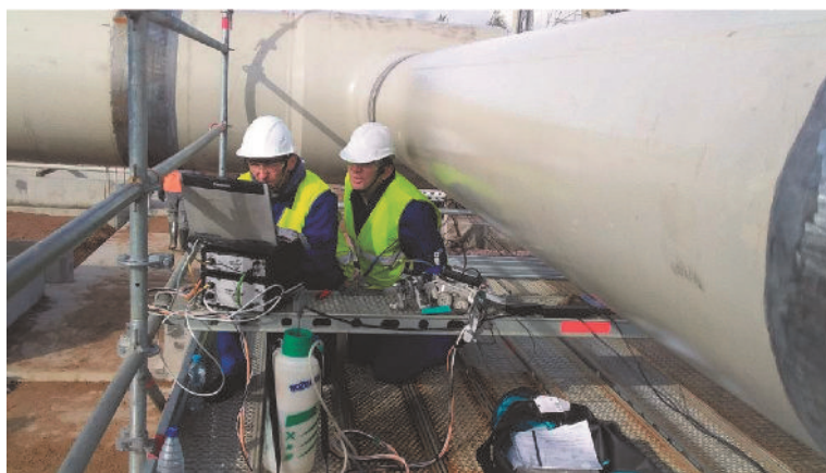
Рис. 9. Контроль системой «АВГУР-ТФ» (ФР+TOFD) кольцевых сварных соединений трубопроводов
