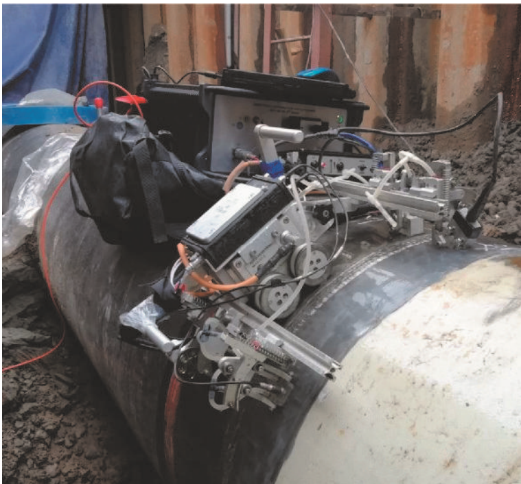
Рис. 9. АУЗК сварного соединения диаметром 720 мм системой «АВГУР-ТФ» со сканером на магнитных колесах
