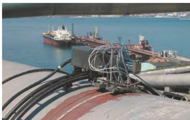
Рис. 15. Контроль системой «АВГУР» на нефтебазе Шисхарис, 2002 год
