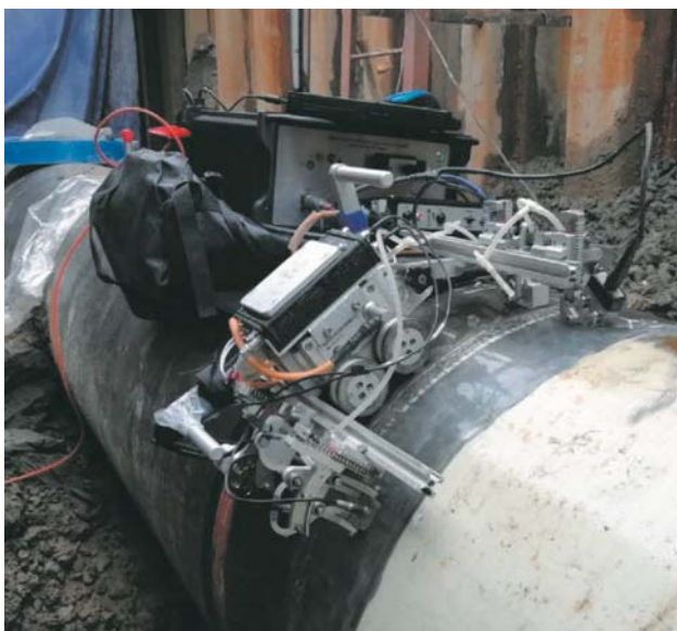
АУЗК сварного соединения диаметром 720 мм системой «АВГУР-ТФ»
