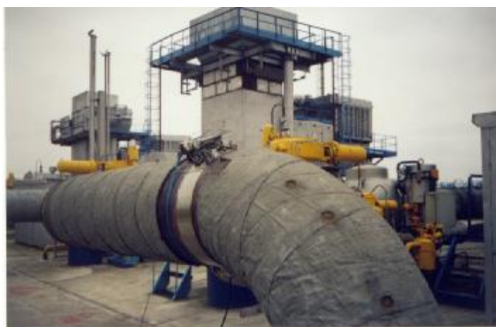
Рис. 11. Контроль системой Авгур трубопровода Ду 1200 на ГКС.
